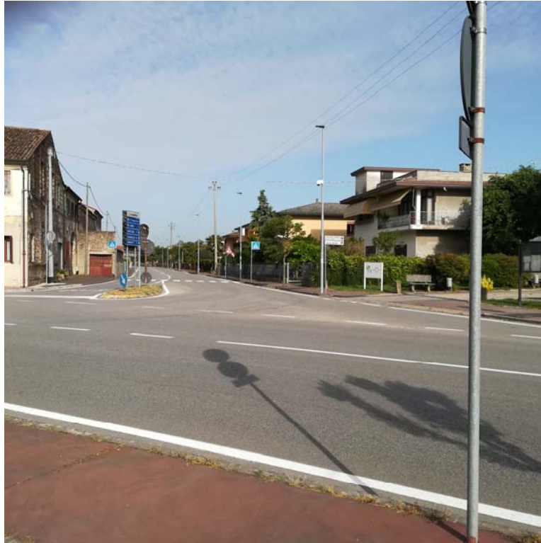
FOTO 1 – DIREZIONE TERRASSA PADOVANA (SP 96)
