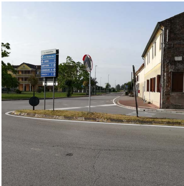
FOTO 3 – VEDUTA DA VIA NAVEGAURO DIREZIONE VERSO ARRE
